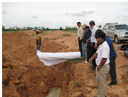
ภาพที่ 1 วางระบบท่อระบายน้ำใต้ดินหุ้มด้วย Geotextite แล้วถมด้วยดิน
