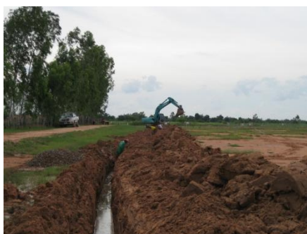
ภาพที่ 1 วางระบบท่อระบายน้ำใต้ดินหุ้มด้วย Geotextite แล้วถมด้วยดิน
